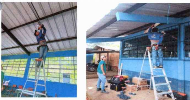
Foto 5: Reparacion de iluminacion del modulo de tres aulas ,direccion y corredor la cual se esta llevando a cabo dicho proceso.
