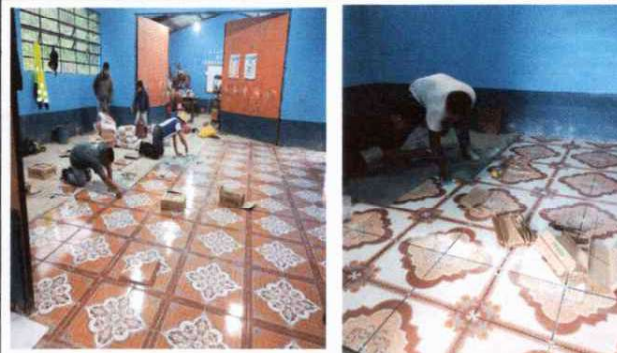
Foto 2: Sustitucion de piso de torta de concreto a piso ceramico, aquí ya se esta trabajando en cada uno de los modulos con el piso ceramico
