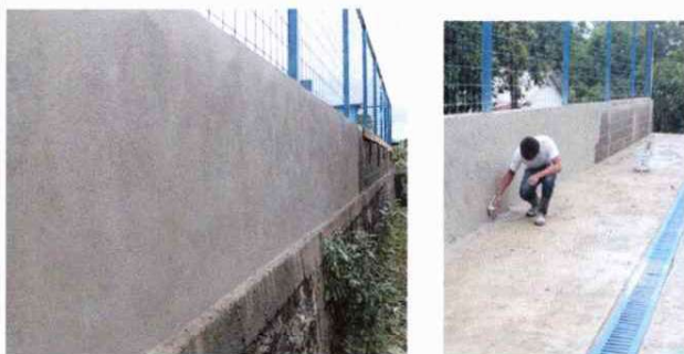
Foto 3: Mantenimiento de muro perimetral de repello con cernido y colocacion de electromalla para mejor resistencia la cual se esta realizando.
