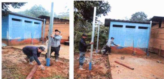
Foto1: Estructura y cubiertas de laminas, En este momento se esta cambiando la galera anterior y se esta colocando la estructura
