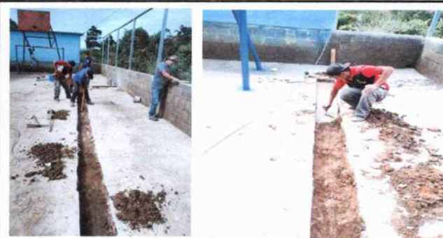
Foto 6: colocacion de rejilla por acumulacion de agua en patio. En este renglon ya se esta realizando dicha accion .
